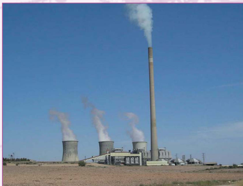
Central térmica "Teruel" de 1.101 MW
