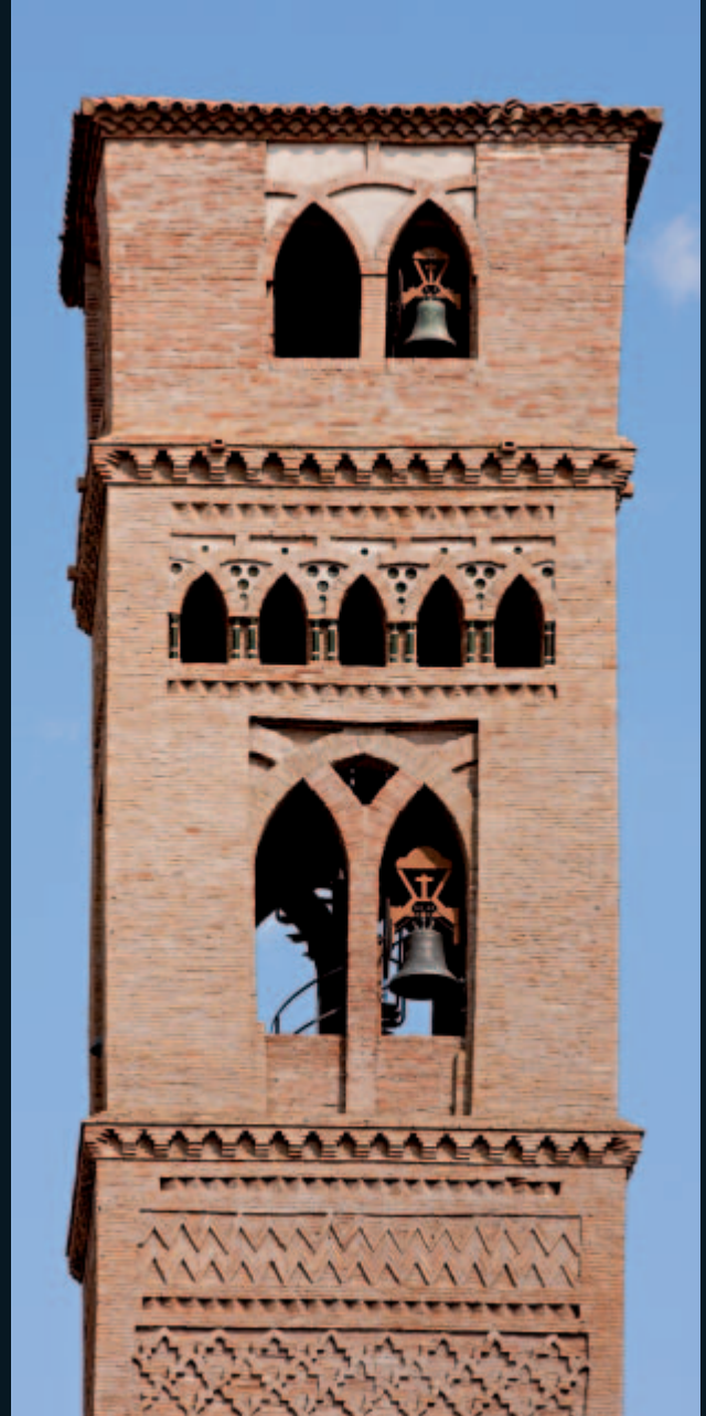
Detalle de la torre Iglesia Aniñón (Zaragoza).
